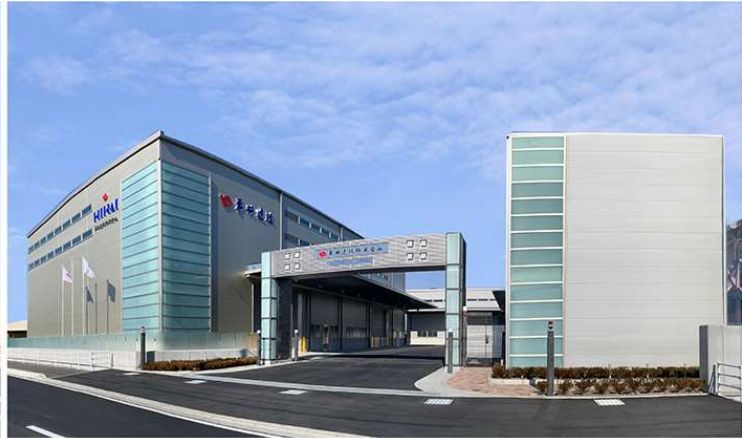
奈良中央機材センター・技術研究所
